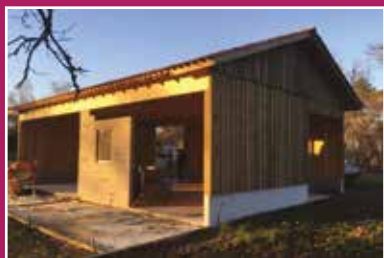
Un bâtiment ouvert pour chevaux en ossature bois
