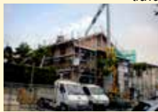
Un chantier de rénovation
