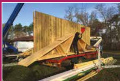
Tout est préparé en atelier. Le montage est donc rapide.
