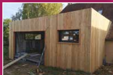
Une extension de maison en cours de chantier
