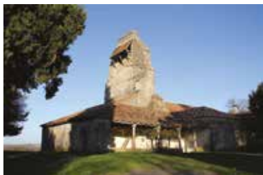
Eglise de Heux : la façade sud.
