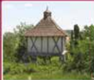
Patrimoine Bâtiments en péril
