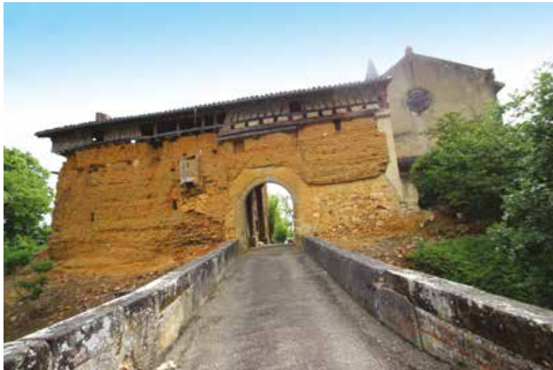
Le rempart du Castet : réalisé en couches de terre crue ou «bauges». Il est unique en Europe.
